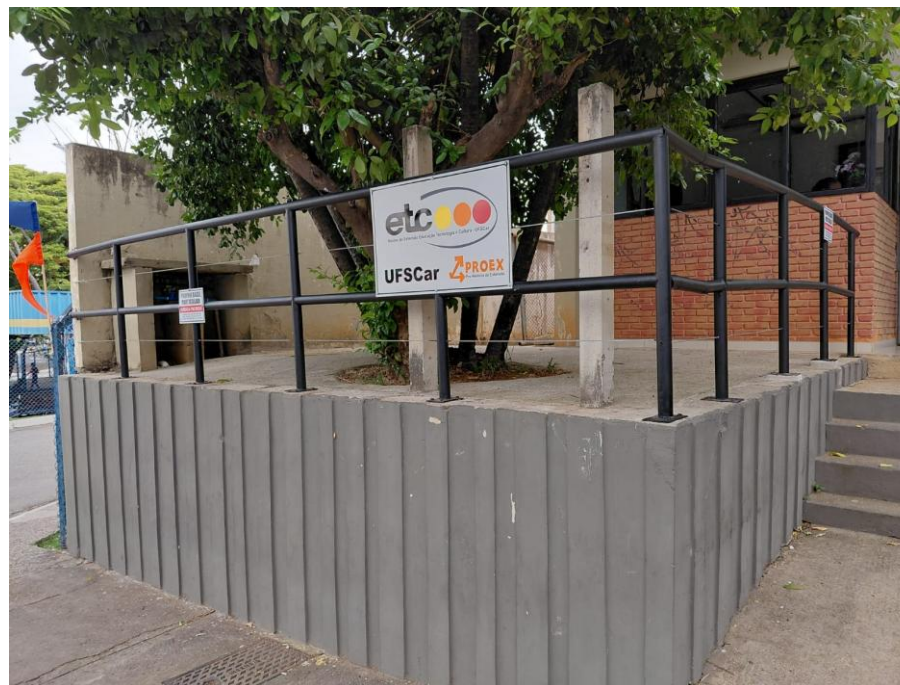
Figura 1 - cercamento na entrada do NETC
