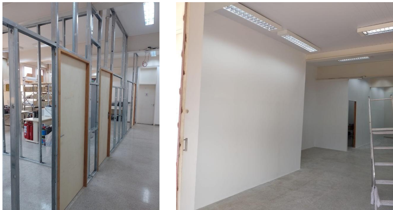
Figura 2 – Divisórias instaladas na PU-So e no COGEF-So.
