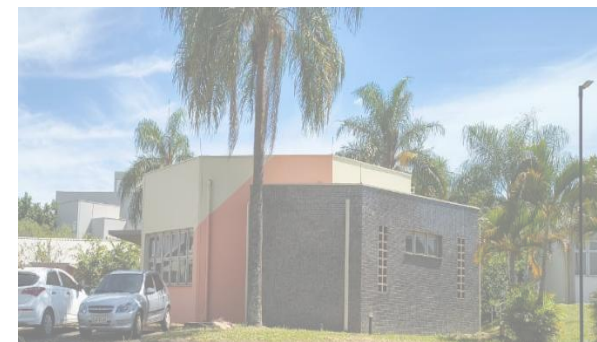
Revitalização do Núcleo de Extensão / Sala de Múltiplo Uso do campus São Carlos
